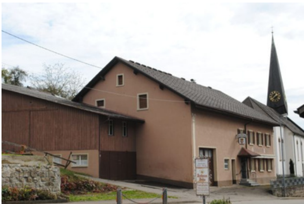
GASTHAUS DREI KÖNIG VOR UMBAU
